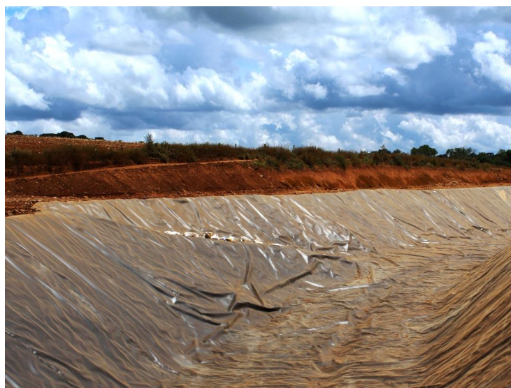
Fig.5. Rampa de fuga para animais silvestres que entrarem no canal
