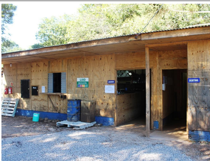
Fig. 02. Instalações de apoio: escritórios, refeitório e almoxarifado
